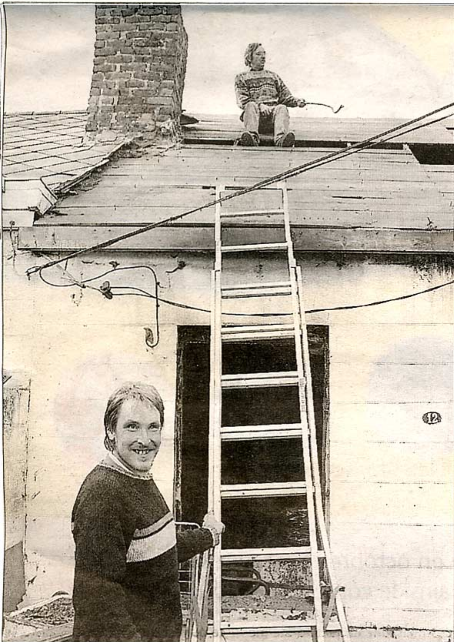
Grégory a retrouvé l'espoir grâce à la générosité du voisinage et l'habileté des bénévoles qui rénovent sa maison. (AV-PRESS)
